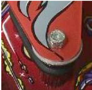
Observa que la arandela se instala entre el poste metálico y el poste de plástico, es decir, se desmonta el plástico de la banda de rebote, luego se desmonta el poste metálico que mantiene el poste de plástico en su sitio, a continuación se mete la arandela en el poste metálico por debajo de la tuerca fija. Vuelve a montar el conjunto poste metálico/arandela/poste de plástico y finalmente reinstala el plástico de la banda de rebote.
